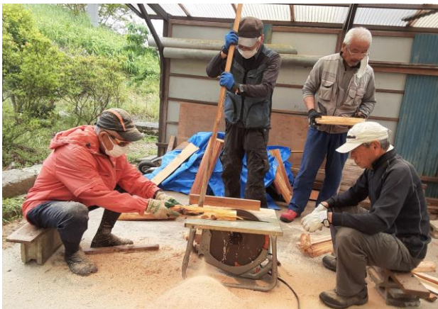
丸鋸盤による切断作業
