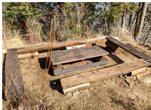
山頂東側の南に完成したボックス型ベンチ
