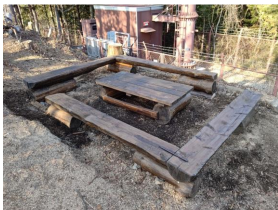
東側中央に完成したボックス型ベンチ
